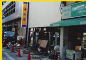
岡山駅前店 （工事中風景・岡山市）
